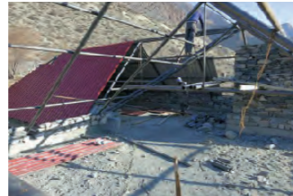
工事は、まだ未完成。完成は4月末
